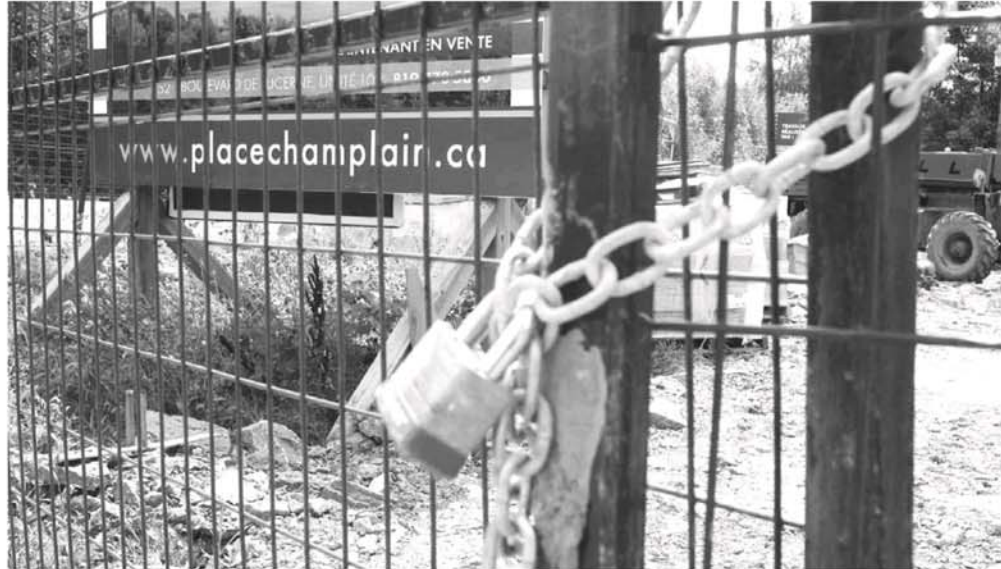
En Outaouais, les activités ont été interrompues sur le chantier des immeubles de condominiums Place Champlain, à l'angle des boulevards Alexandre-Taché et Saint-Raymond.
